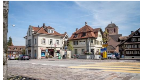
Das Gebiet Zentrum/Flecken ist erstes Prioritätsgebiet für einen Wärmeverbund.
