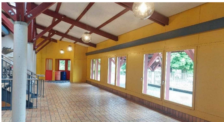
Mit der Sanierung erhält die Chärnshalle eine moderne LED-Beleuchtung.
