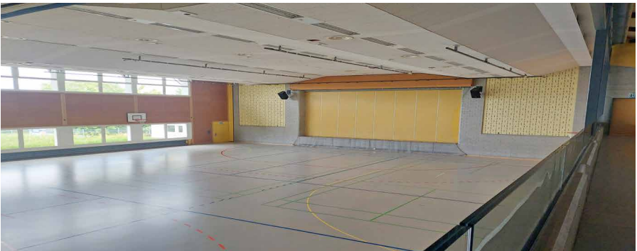
Mit dem Ersatz der Hallenfenster erhält die Chärnshalle neue Notausgänge direkt ins Freie.
