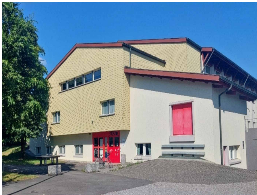
Der Eingang zum Jugendraum befindet sich an der Südfassade der Chärnshalle.
