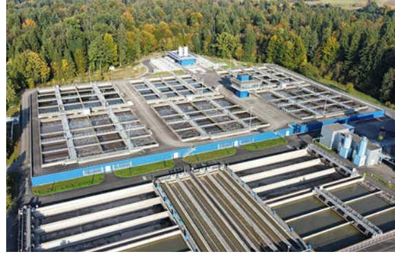
Die ARA Buholz in Emmen ist die grösste Abwasserreinigungsanlage der Zentralschweiz.
