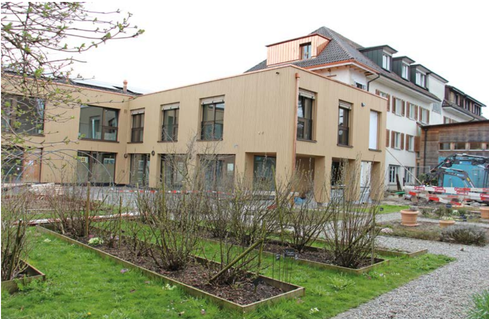
Mitte Mai beziehen die Bewohner den fertiggestellten Neubau.
